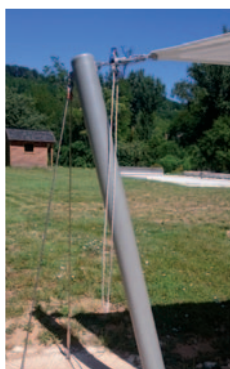
Abrivoile enrouleur, la voile se replie en s'enroulant
