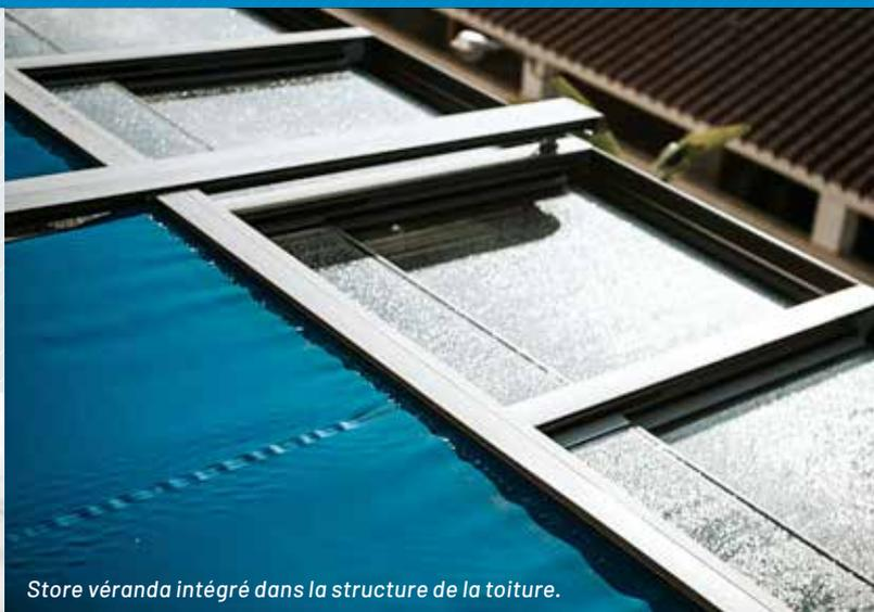
Store véranda intégré dans la structure de la toiture.
